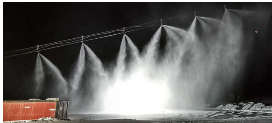
↑ Abb. 2: Testanlage 2021/22 Schneiseil an der Talstation Diavolezza. (Foto: zVg)
